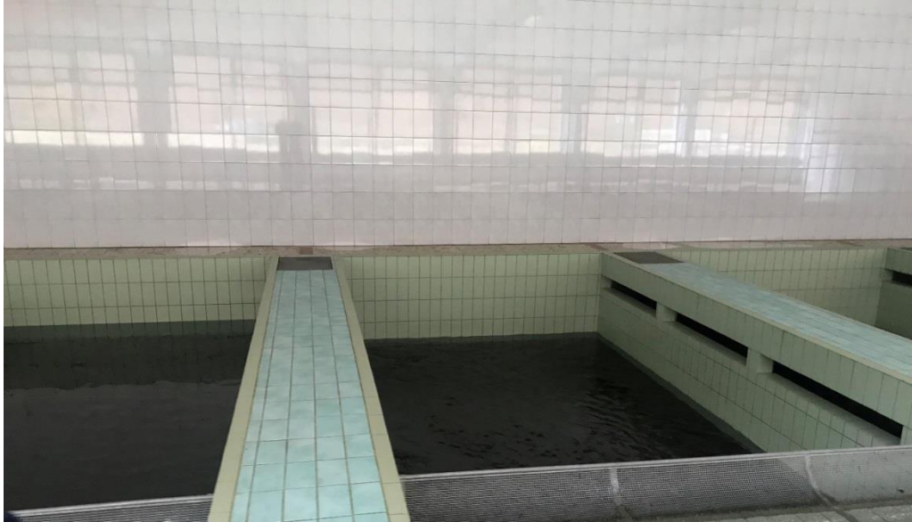
Slika 5. Filtarska polja - Izvorište Lobor
