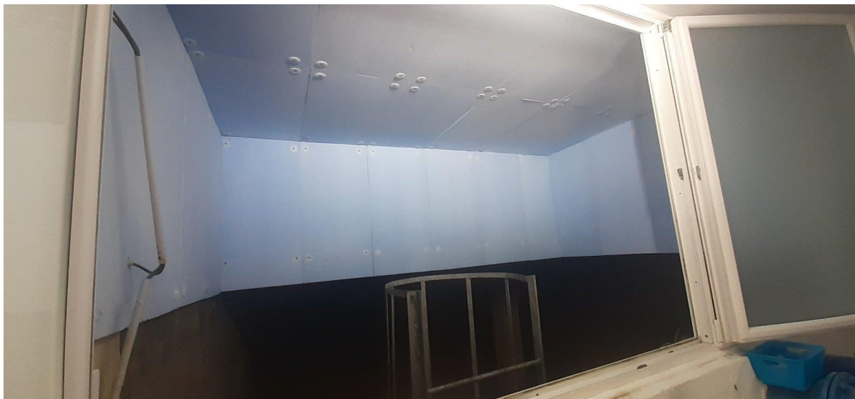
Slika 8. Prostor unutar vodne komore - Harina Zlaka poslije provedenih ispravaka
