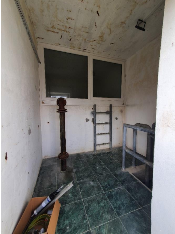
Slika 7. Prostor unutar vodospreme Brezje (prije provedenih ispravaka)
