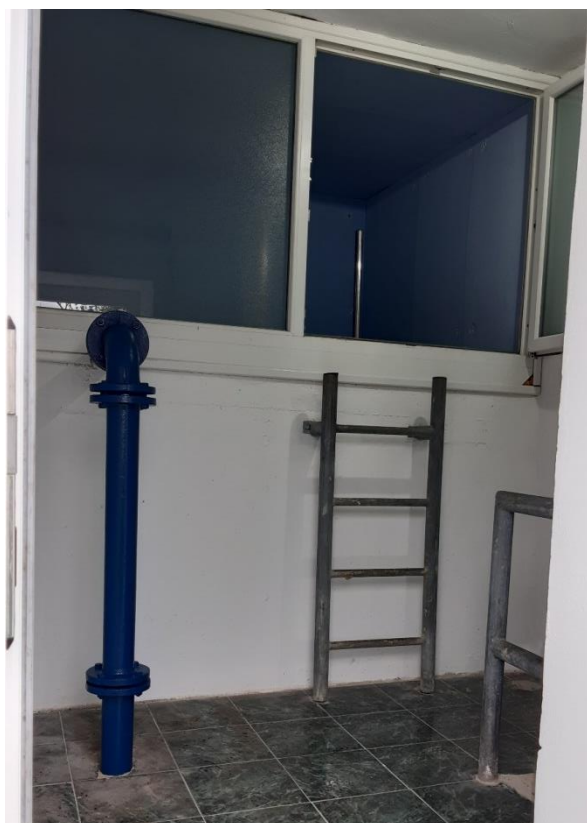
Slika 9. Prostor unutar vodne komore - Harina Zlaka poslije provedenih ispravaka
